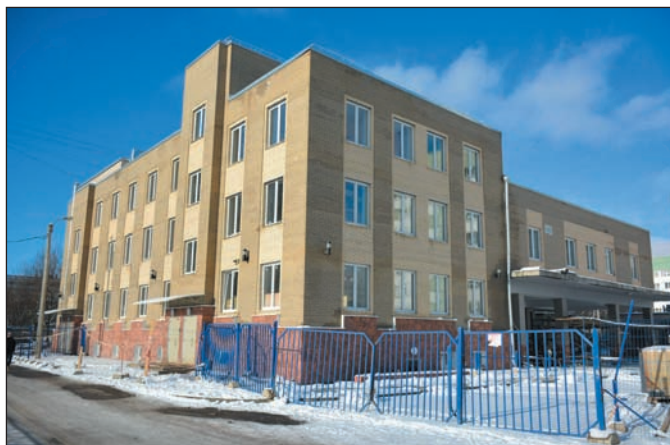
В новой пристройке поликлиники N88 скоро разместится станция скорой помощи
