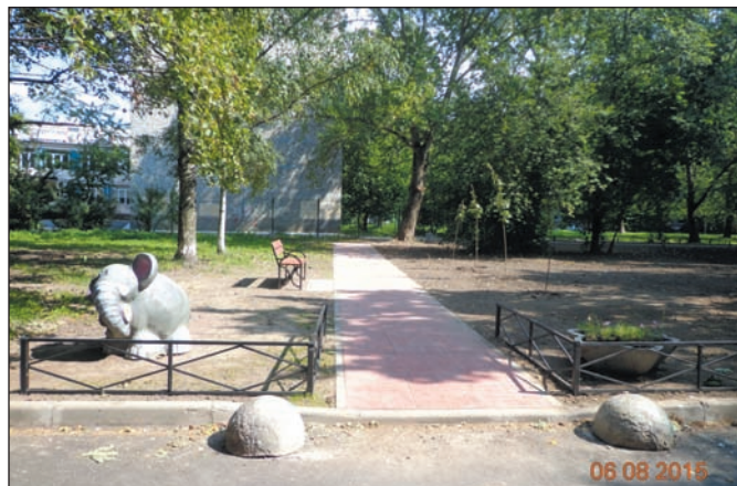
Мощение пешеходной дорожки у дома 84 по пр. Ветеранов
