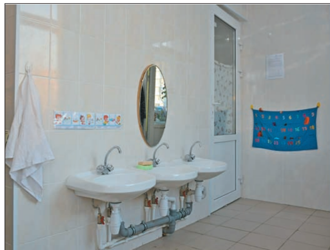
Косметический ремонт в туалетной комнате с заменой сантехники, облицовкой стен и пола кафельной плиткой в детском саду N59
