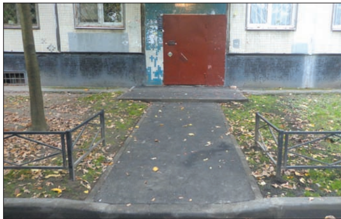
Ремонт подхода к подъезду дома 17 по ул. Солдата Корзуна
