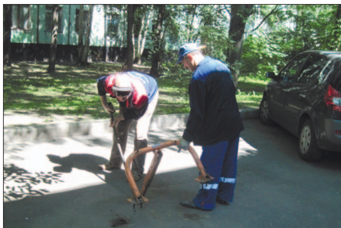
Демонтаж устройств для резервирования стоянки по адресу: пр. Маршала Жукова д. 56, корп. 8
