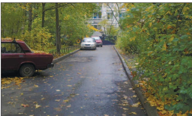
Отремонтированное асфальтовое покрытие у дома № 15 по ул. Солдата Корзуна.
